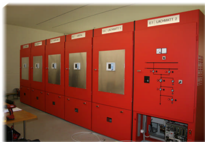
Vor Umbau des letzten Feldes
